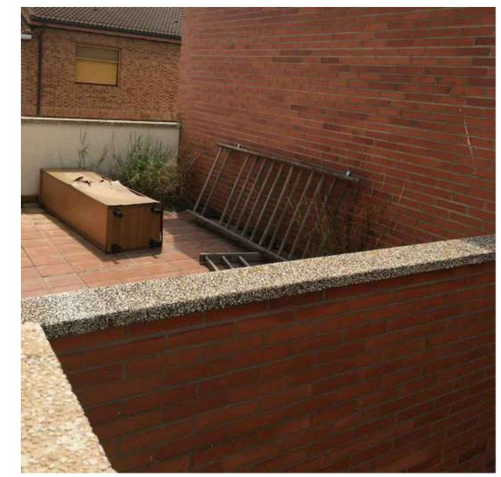
VISTA 04 Demolición de cubiertas planas y antepechos de terrazas traseras
