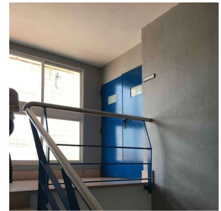
VISTA 05 Desmontado de ventanas rejas y remates en planta primera
