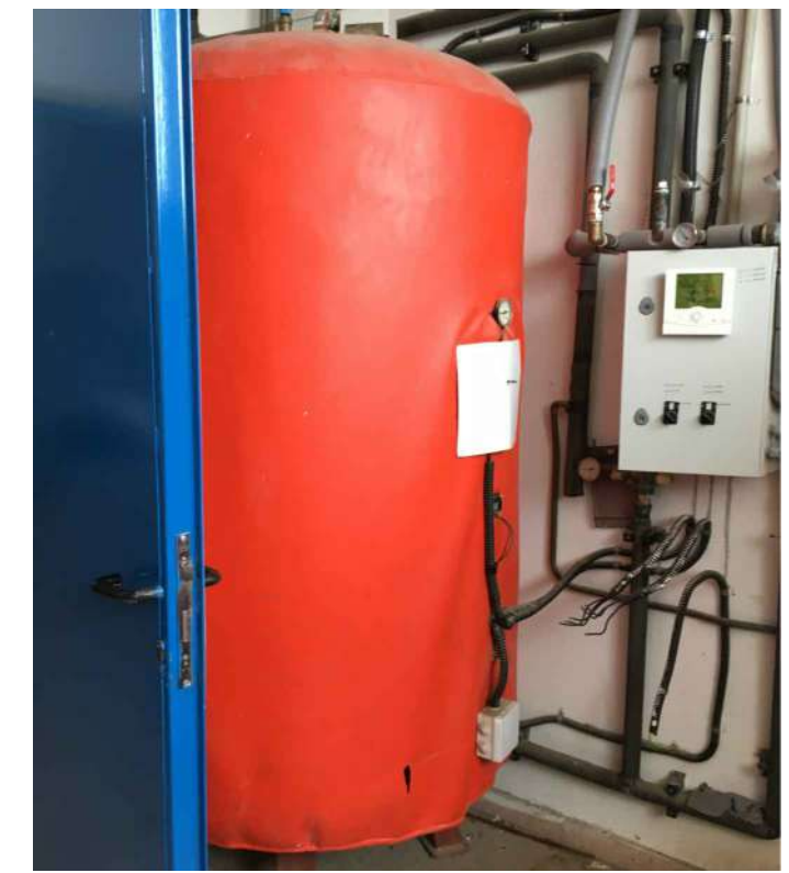
VISTA 03 Desmontaje de depósitos de ACS existentes en cuartos de instalaciones
