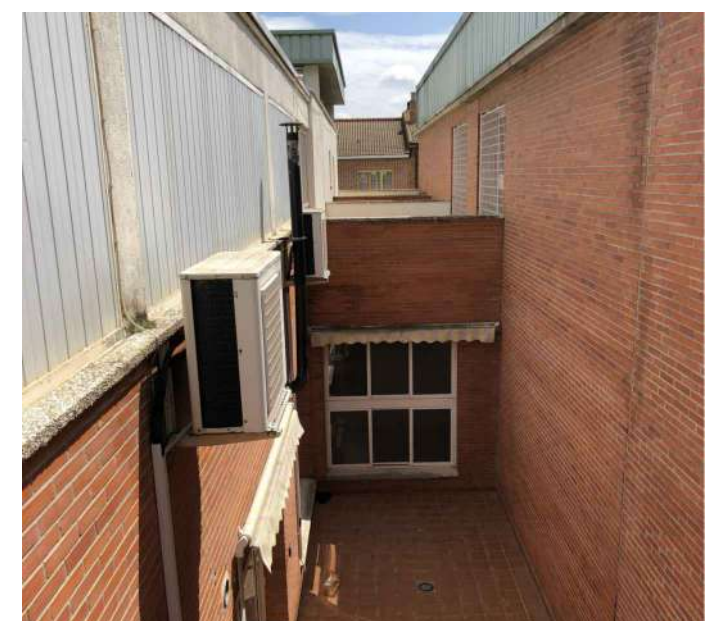
VISTA 07 Petos a demoler en terrazas y zanjo patios para conexiones de pluviales
