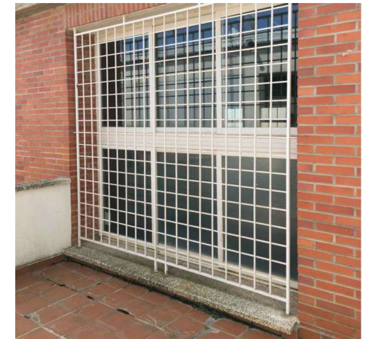
VISTA 08 Desmontado de ventanas rejas y remates de huecos polideportivo
