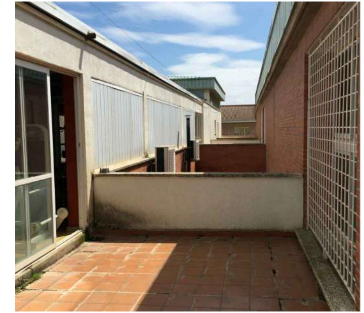
VISTA 06 Levantado de cubierta plana en terrazas traseras
